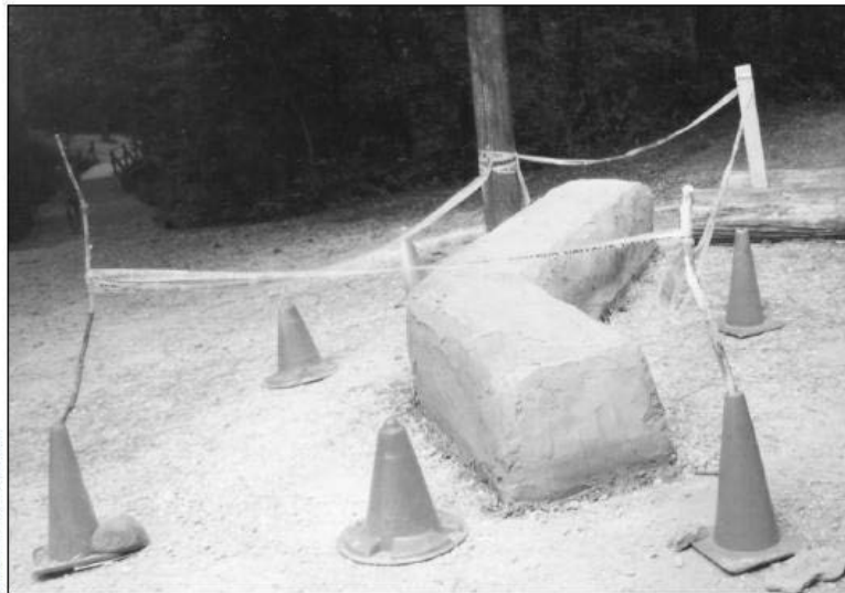
Un banc pour le patio, construit avec 3 ballots de paille
